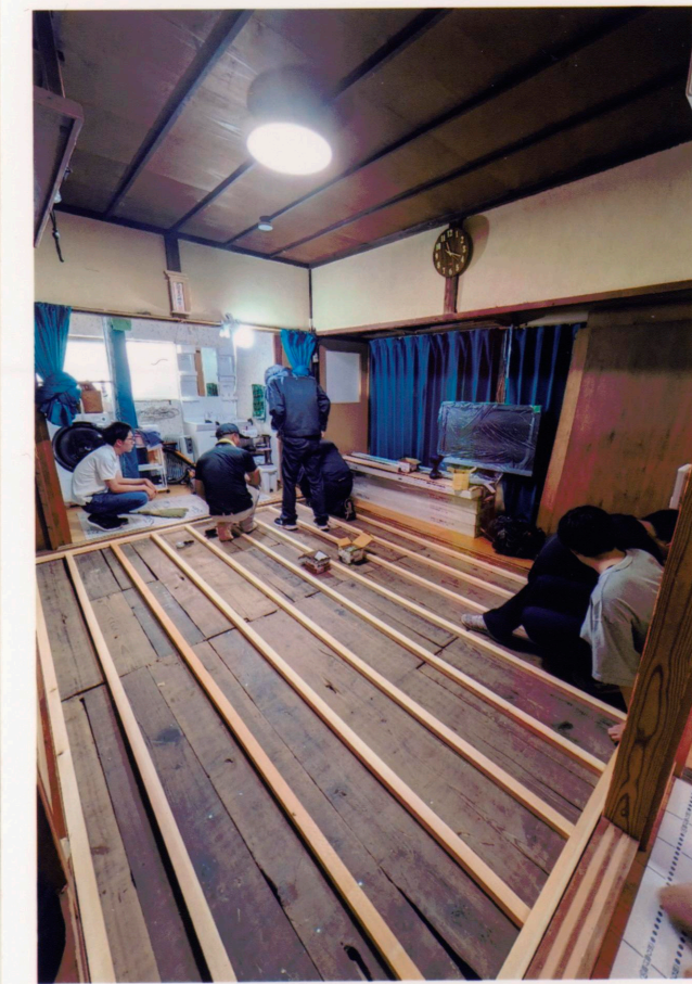
断熱材敷き込み
