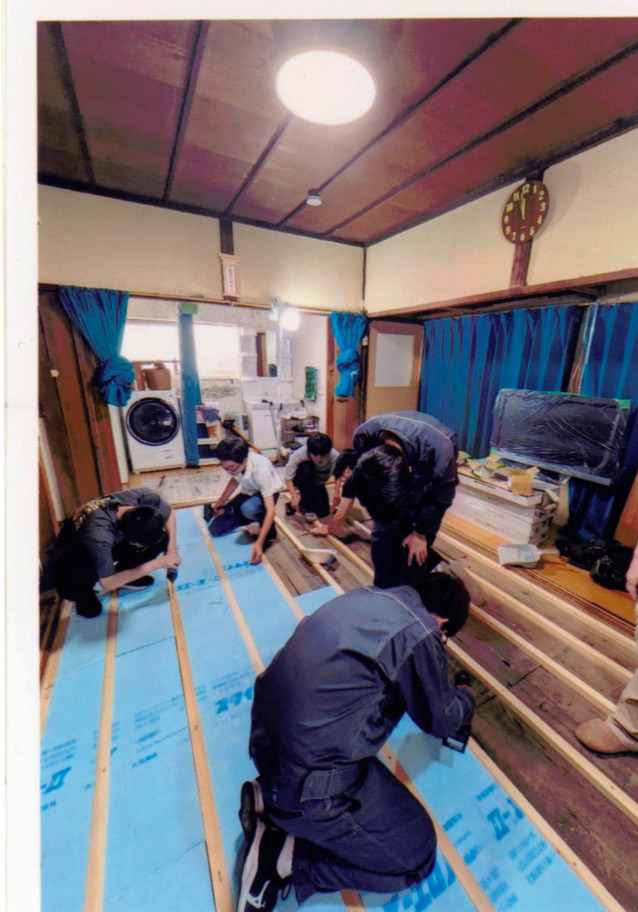
断熱材敷き込み
