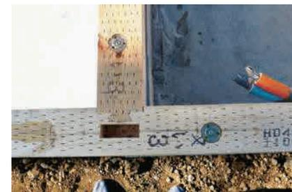
写真1 仕口位置とアンカーボルトの位置確認
